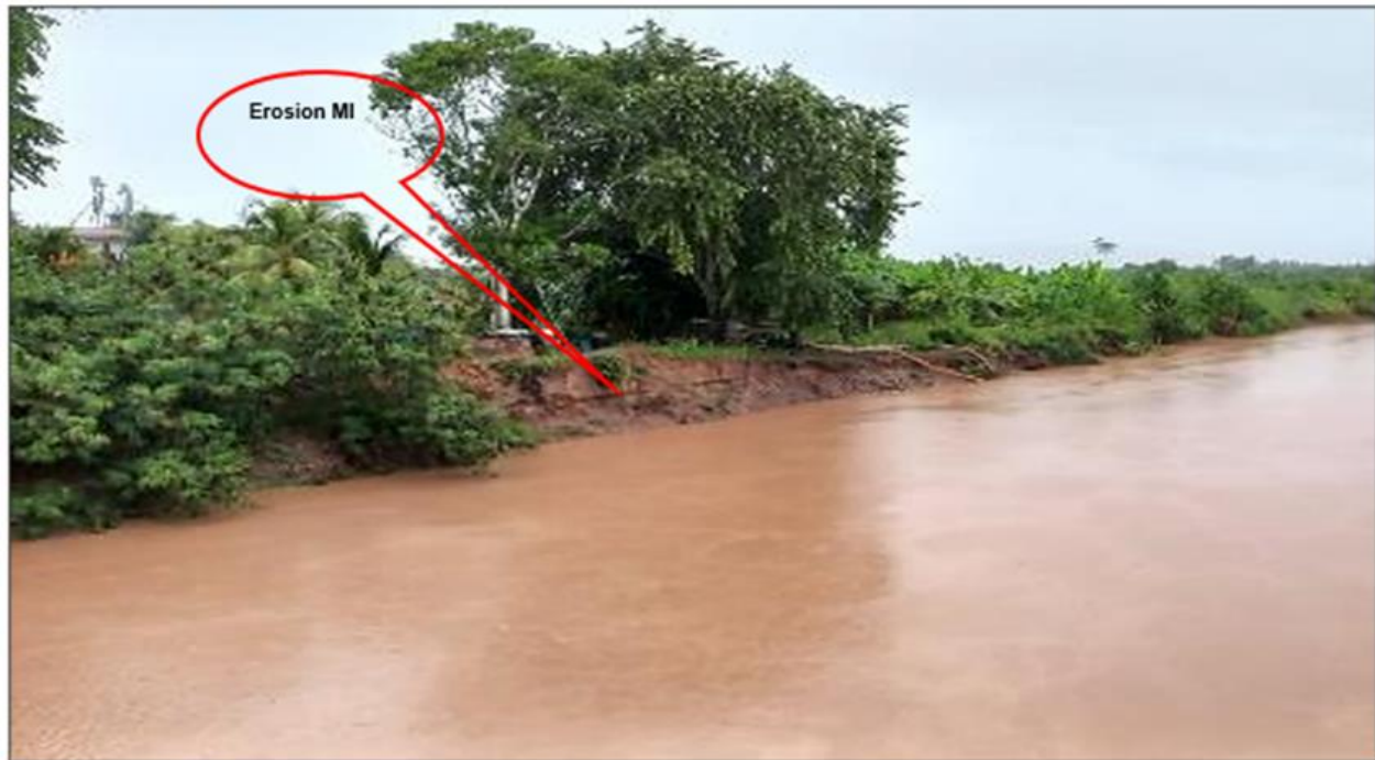
FIGURA N°02.- EN LA VISTA FOTOGRAFICA SE MUESTRA EL TRAMO CRÍTICO EN EL RÍO SISA, MARGEN IZQUIERDA, EL CUAL PRESENTA EROSION DE LA RIBERA
