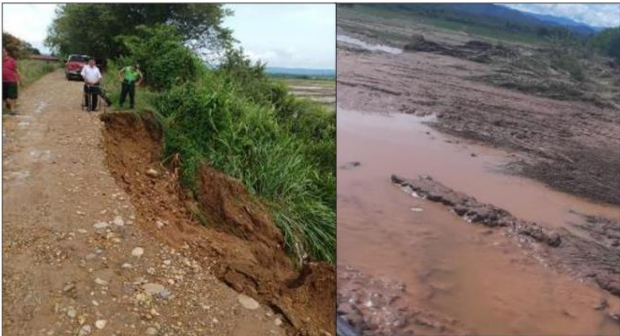
FIGURA N°03.-SE OBSERVA EROSION DEL TALUD E LA RIBERA Y LA INUNDACION DE LA CARRETERA SAN HILARION - NUEVO EGITPO, AFEECTANDO A LA POBLACION Y AGRICULTORES DE LA ZONA.
